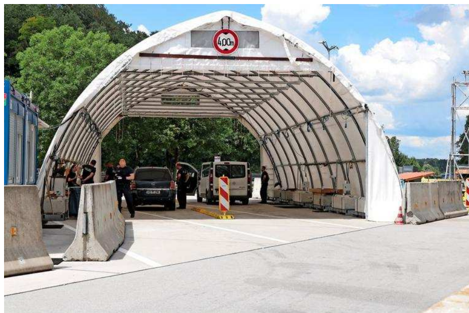
Vom Provisorium zur Dauereinrichtung: Kontrollstelle an der Autobahn 3. Quelle: Christian Neffe
